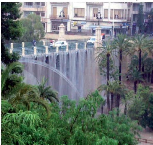
Inundación en el puente Canalejas. Elx (Alicante) 2009.
